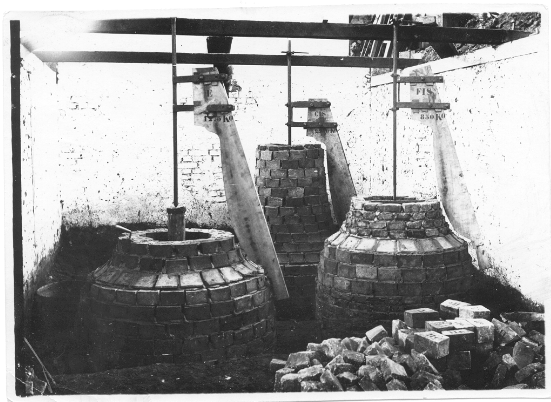
De stenen aanzetten van een aantal kernen in 1916 bij de Koninklijke Klokkengieterij Petit & Fritsen te Aarle-Rixtel.
