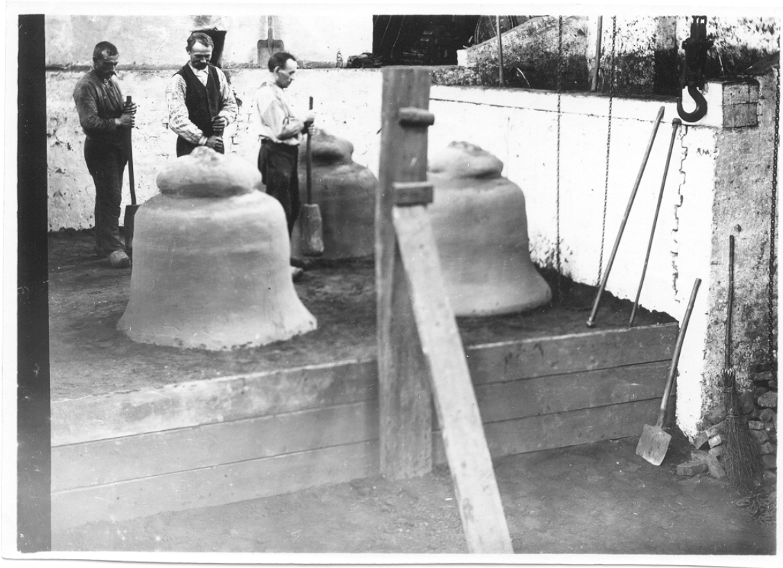
De klokkenvormen worden in 1916 bij de Koninklijke Klokkengieterij Petit & Fritsen te Aarle-Rixtel in de gietkuil opgestampt.
